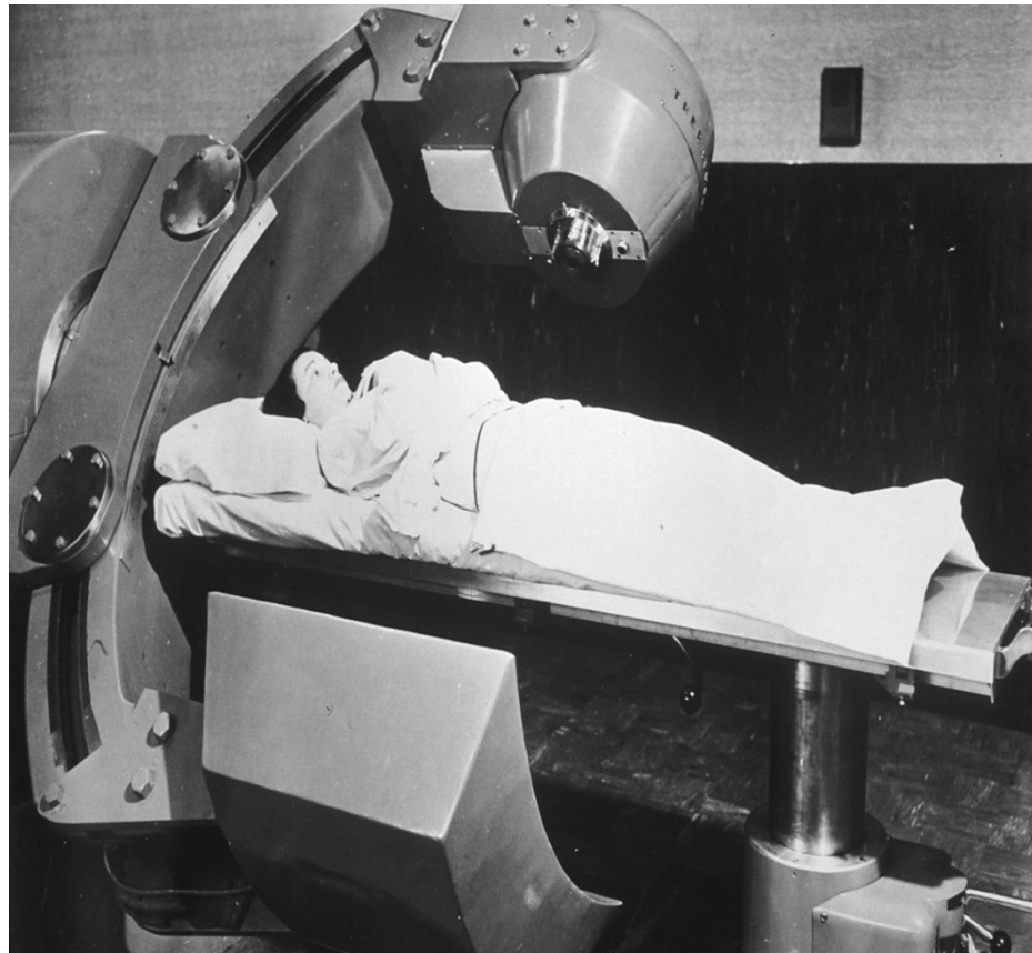
Unità di cobaltoterapia impiegata per il trattamento del tumore della mammella
